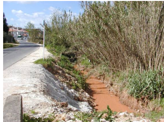
Foto 4 – Rib. Reveles: a jusante do entubamento
