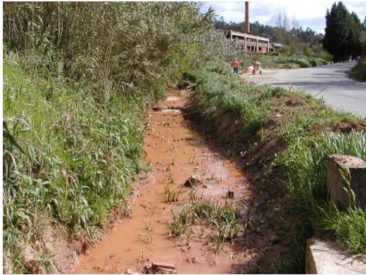
Foto 1 – Rib. Reveles: a montante do entubamento
