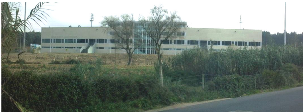
Estádio Municipal Sérgio Conceição - edifício de serviços de apoio
