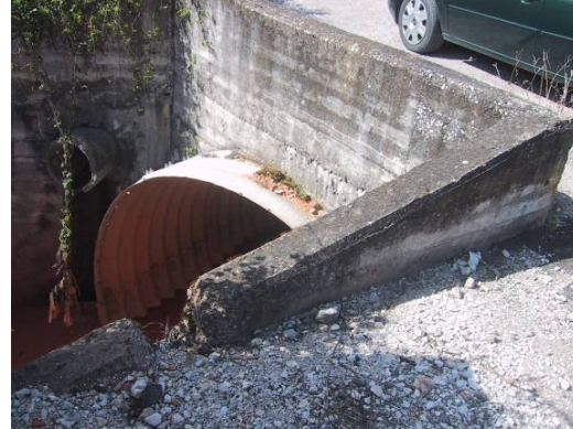
Foto 8 – entrada do “túnel” (para atravessamento da zona de entrada do Mercado Abastecedor)
