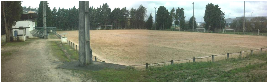
campo de jogos municipal de Taveiro, em avançado estado de degradação
