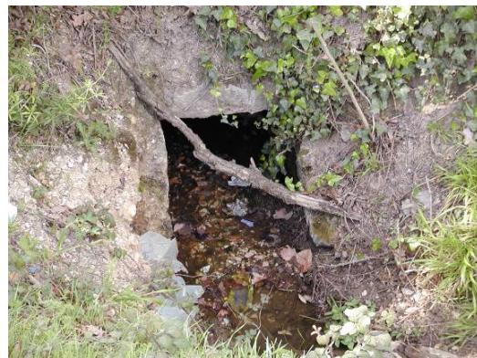
Foto 12 – “colector” de travessia
